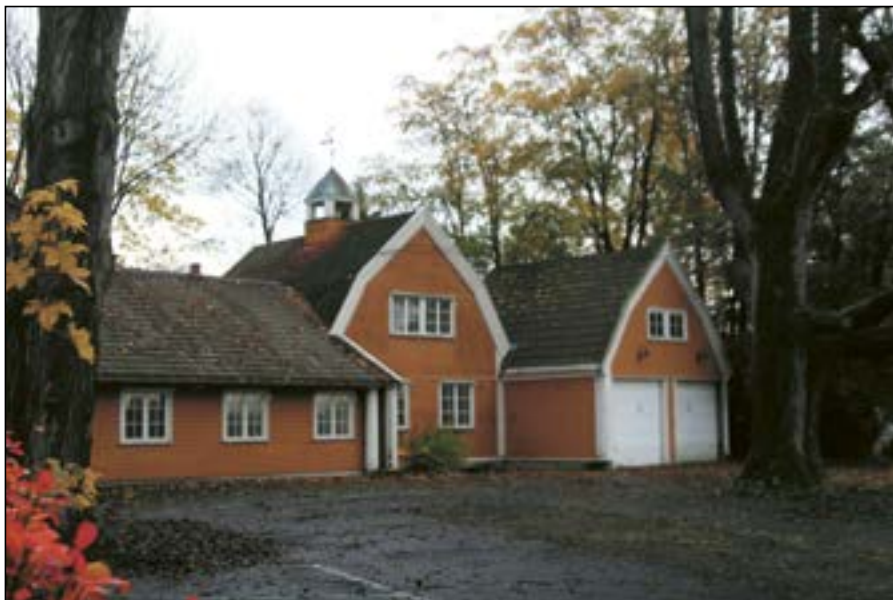
Ekelyveien 2, tjenerleiligheter og garasjer som skal saneres. De erstattes med ni barnehageavdelinger.
