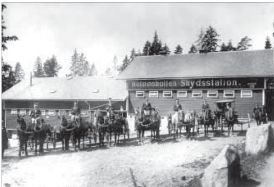
Holmenkollen Skydsstation. Vinderen Historielag.
