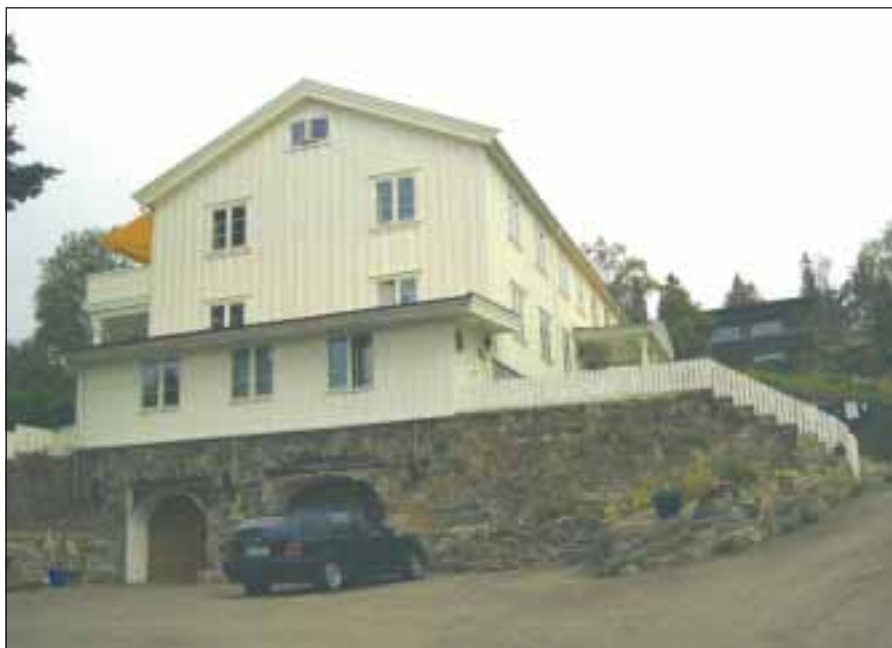
Holmenkollveien 104 med den opprinnelige grunnmuren. Begge foto: Finn Holden.
