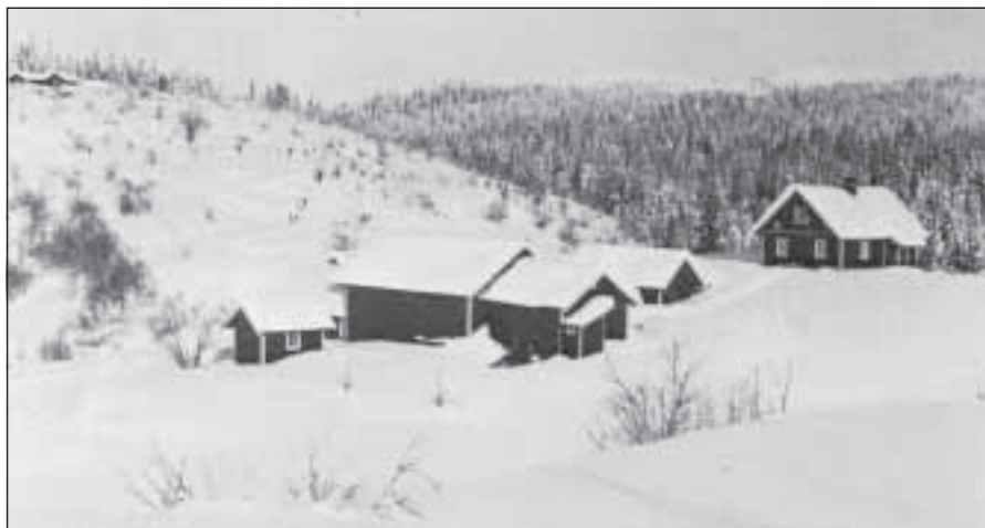
Over: Blankvannsbråten 1930. Fra "Nordmarksfolk" av Egil Collett Aabel. Til høyre: Blankvannsbråten 1947. Fra "Nordmarka og Krokskogen" av Gunnar Raabe.
